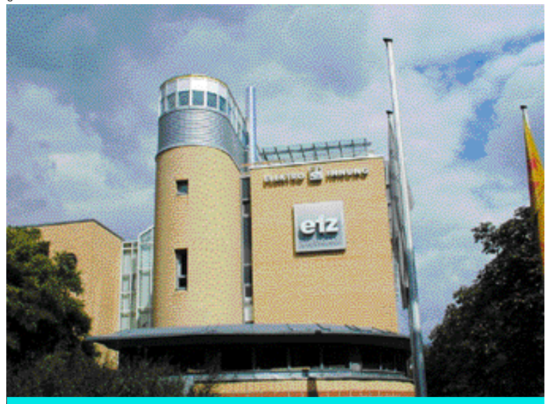
Bild 5: Beim Neubau des Kompetenzzentrums ELKOnet des Elektrotechnologie-Zentrums in Stuttgart (etz Stuttgart) wurde jetzt erstmals ein vollständig dezentral strukturiertes System für die TGA unter Berücksichtigung der Anforderungen an einen hochverfügbaren und kostengünstigen Betrieb des Gebäudes umgesetzt.
